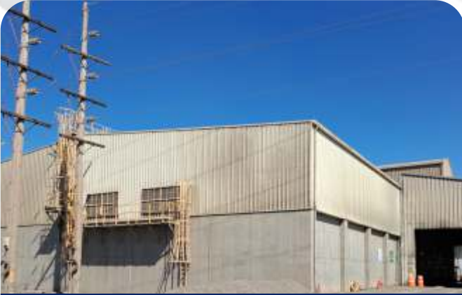
ALMACÉN DE CONCENTRADOS
